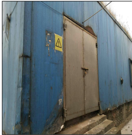
磷酸库入口处的危险标识
