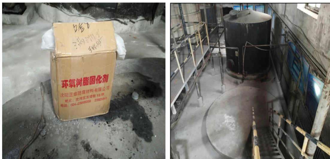
图 4.1-1 池体类现场排查照片
