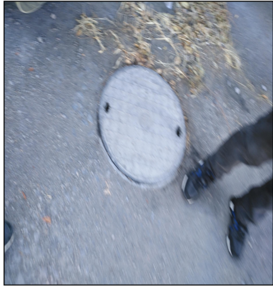
生活污水进入园区管网的出口
